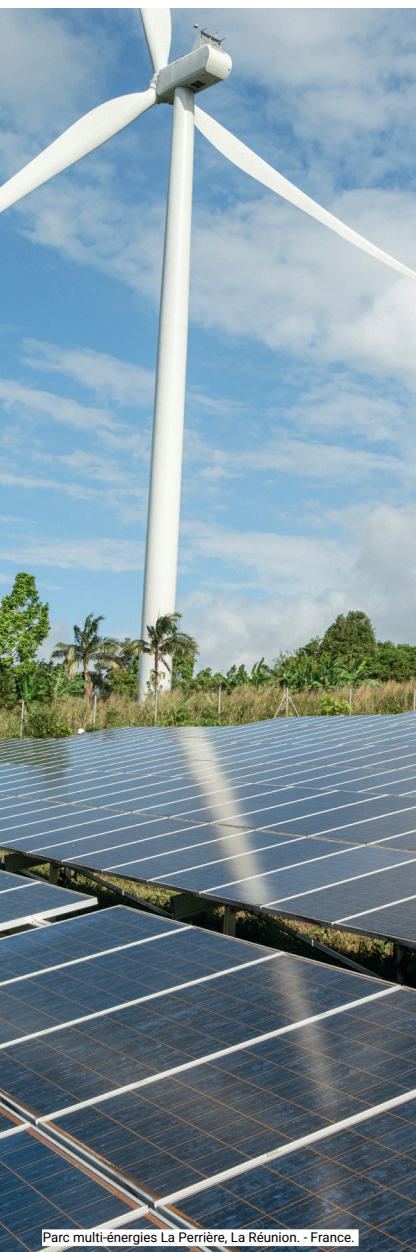
Parc multi-énergies La Perrière, La Réunion. - France.
