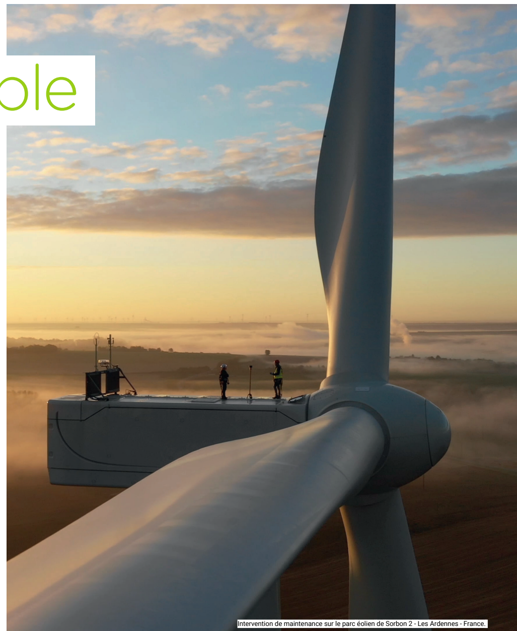
Intervention de maintenance sur le parc éolien de Sorbon 2 - Les Ardennes - France.
