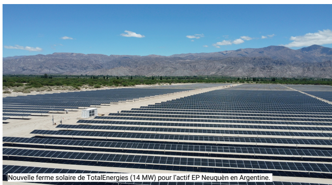
Nouvelle ferme solaire de TotalEnergies (14 MW) pour l'actif EP Neuquén en Argentine.
