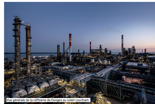
Vue générale de la raffinerie de Donges au soleil couchant.
